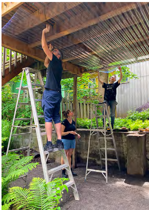
Membres de la coopérative Pétunia travaillant sur un abri pour les vélos
