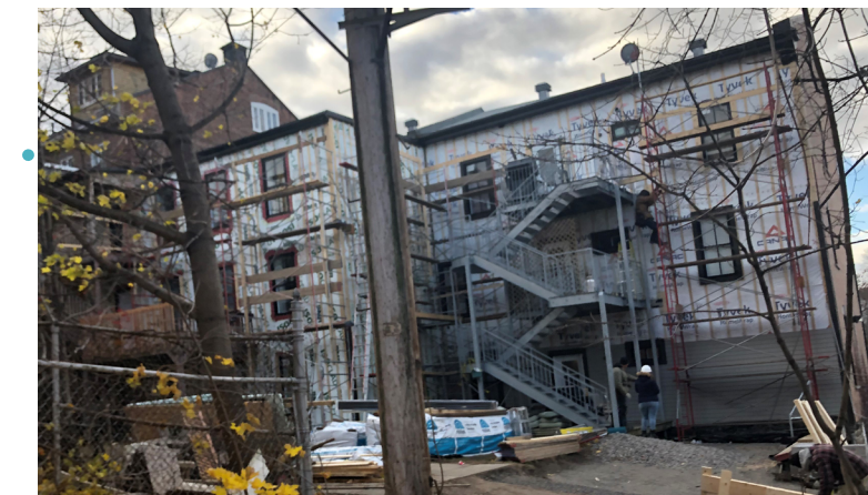
Chantier Côte du Passage
